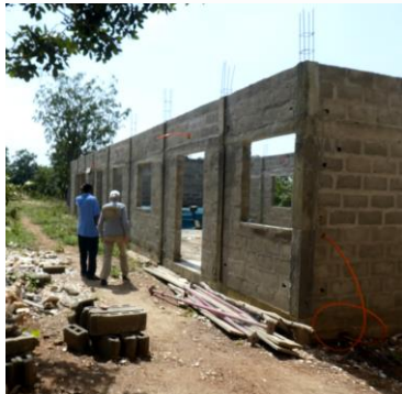
Leslokaal in aanbouw
